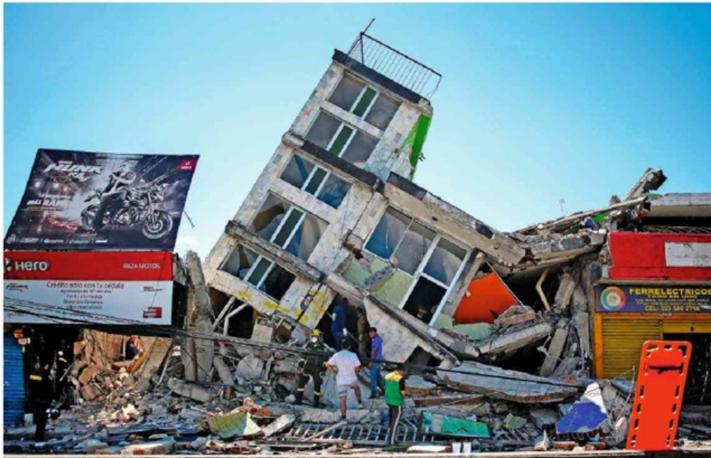
Equipes de resgate e moradores buscam sobreviventes em prédio que desabou em Dosquebradas, na Colômbia Juan David Duque/Reuters
