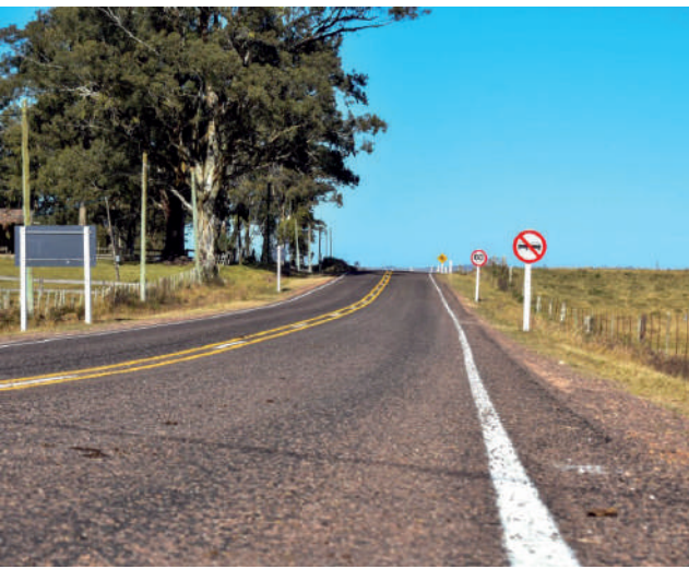
Trabajos de obras en Ruta 29 Foto: AP
